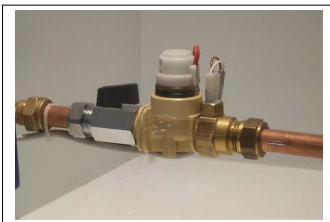
Temperatuursensor geïntegreerd in magneetventiel
