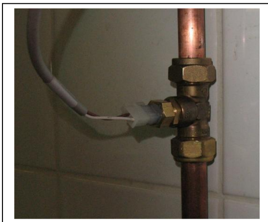
Temperatuursensor gemonteerd in waterleiding
